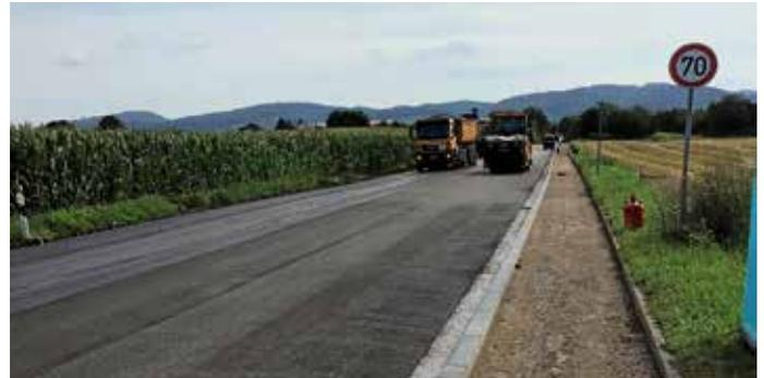
Die neue Fahrbahndecke im 1. Bauabschnitt der L 541 wird eingebaut.
