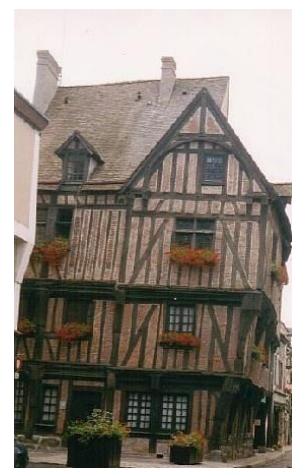
Die sogenannte Maison de l'Obrador
